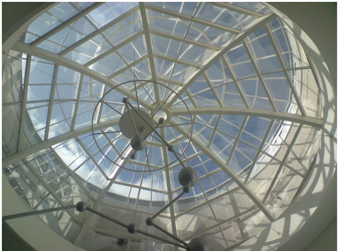
Figura 23 – Vista das cúpulas pelo interior do prédio
