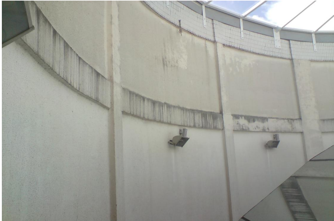
Figura 26 – Parede de alvenaria entre as cúpulas
