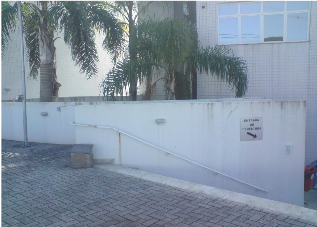
Figura 11 – Muro da entrada principal
