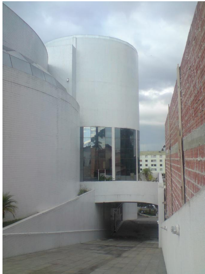
Figura 14 - Vista externa da fachada envidraçada localizada no piso térreo
