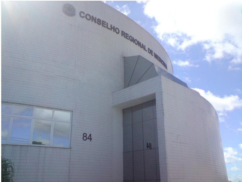
Figura 01 – Fachada da frente do prédio da Sede do CRM-PR
