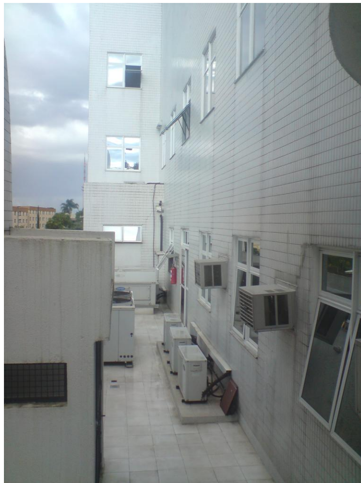
Figura 04 – Vista lateral do prédio, mostrando os equipamentos de ar condicionado
