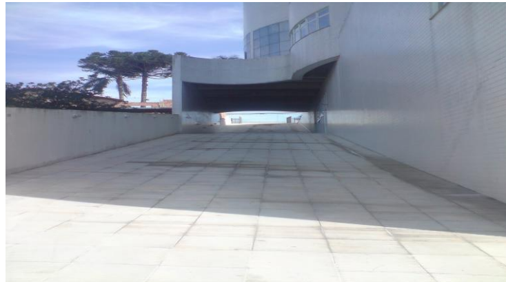
Figura 13 – Rampa de acesso
