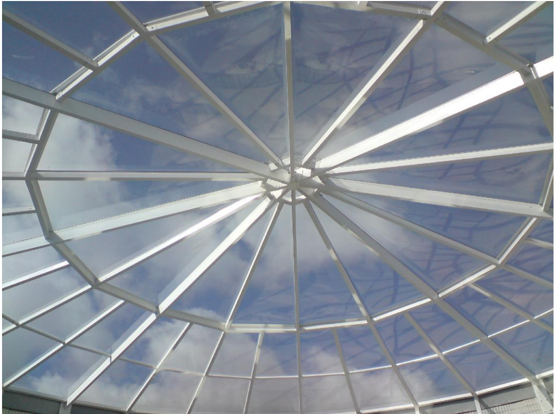
Figura 24 - Vista interna da cúpula maior (acrílico cristal compacto)
