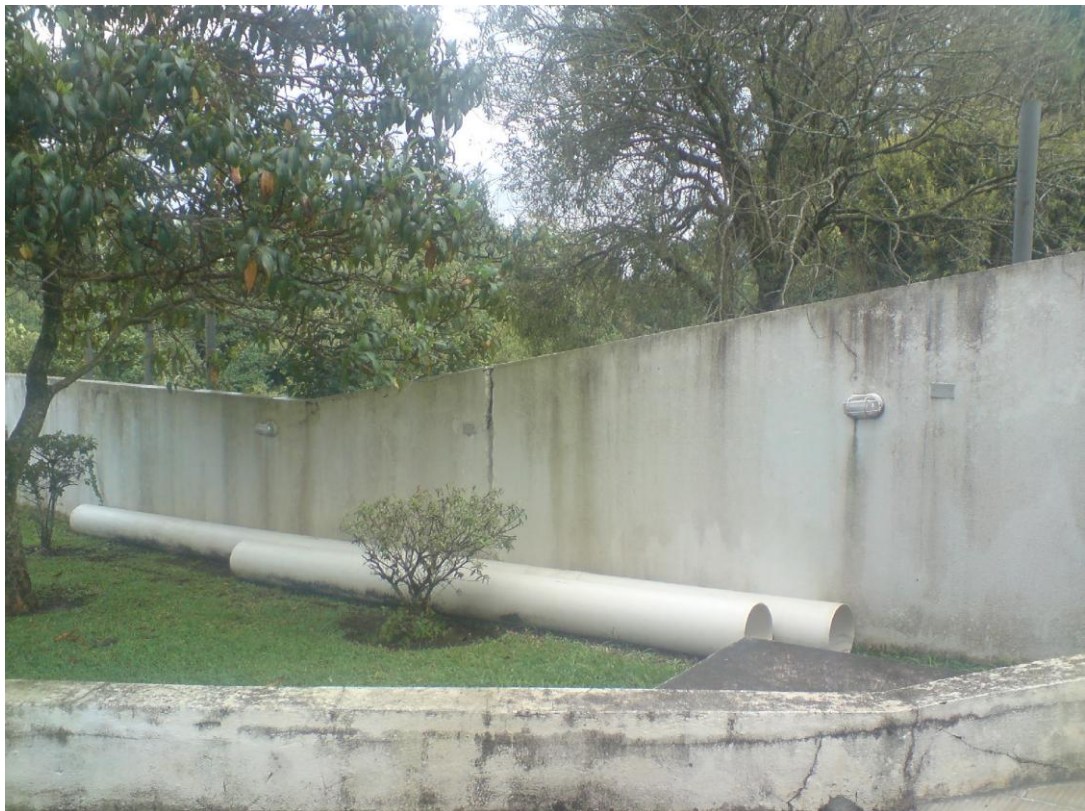
Figura 10 – Muro lateral do estacionamento descoberto
