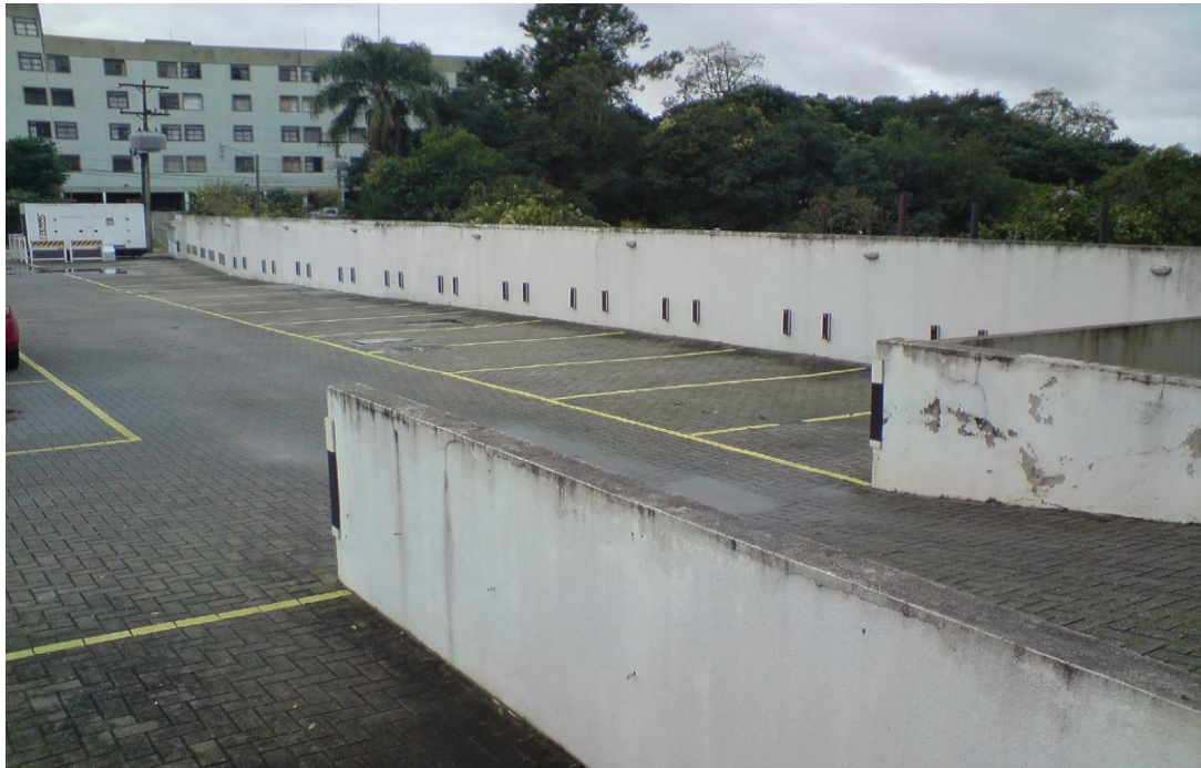
Figura 07 – Muros do estacionamento descoberto
