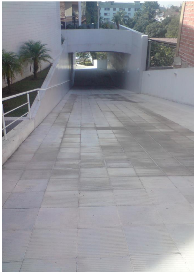
Figura 12 – Rampa de acesso ao estacionamento (vista pela entrada principal)
