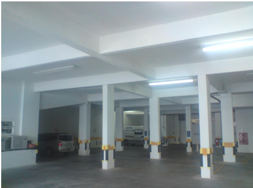
Figura 05 – Estacionamento coberto da Sede do CRM-PR
